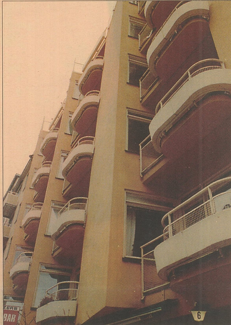
Pilotfall. Bostadsrättsföreningen Fågelbärsträdet lånade 16 miljoner kronor för att bygga om fastigheten på Kungsholmen i Stockholm. När staten höjde den garanterade räntan efter två år stämde föreningen staten för kontraktsbrott. Utgången av målet berör hundratals föreningar runt om i landet.
