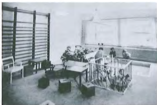
Illustration 20: Del av barnavdelningens lekrum. Fönstren i bilden vetter mot bakgården.
