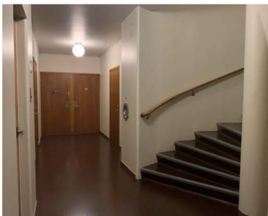
Entrédörrarna har ytskiktsrenoverats genom rengöring och oljning/vaxning. Samtliga beslag har behållits, skyltning hålls enhetlig enl brf's regler.
