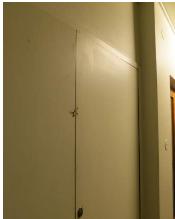
Befintlig beslagning till luckor kompletteras och lagas av snickare innan målning.
