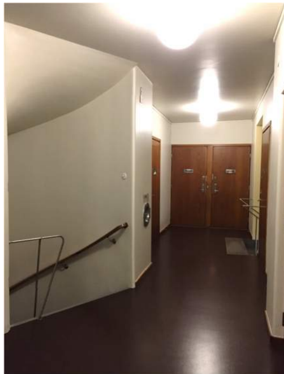
Nytt trappräcke till skydd från att falla ner i källartrappan till vänster. Utformning inspirerad av huvudtrappan i fonden och nedan, design AIX Arkitekter.
