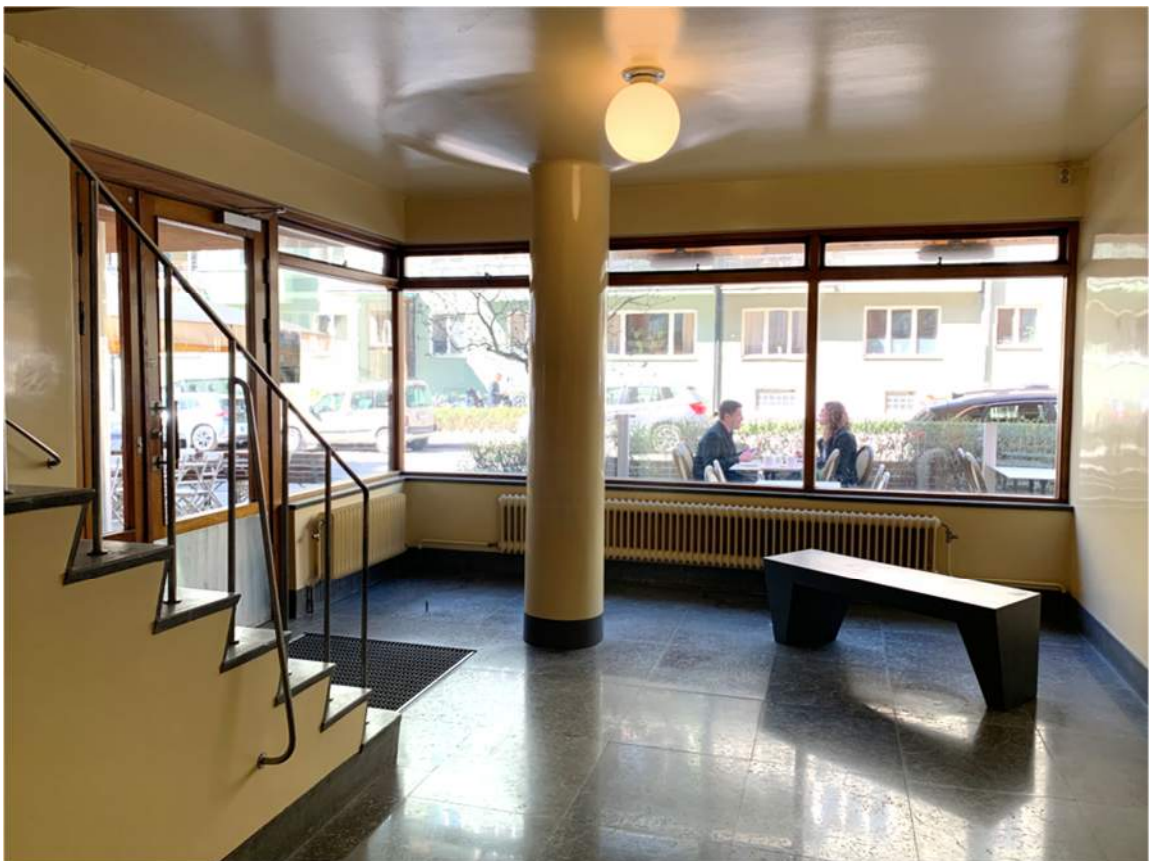
Entrévestibulens golv har återfått kalkstenens varierande kulörer efter borttagning av många lager gulnad polish.
