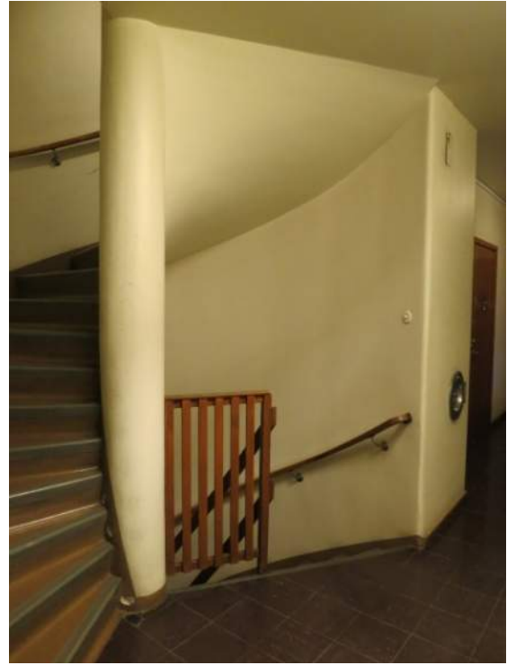
Ta ställning till befintligt räcke till källaren. Jfr med trappräcket till entréplanet, nedan.
