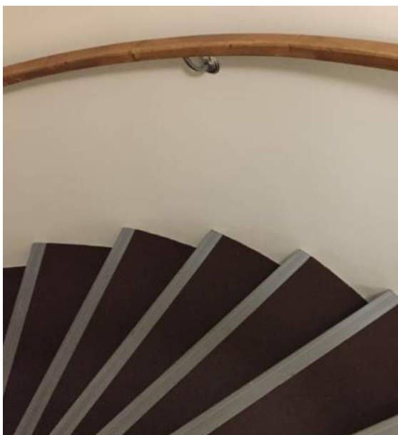
Våningsplanens nya ytskikt av gummiplattor ska motsvara den ursprungliga golvbeläggningen. Gummigolven beskrevs ursprungligen som ljuddämpande.
