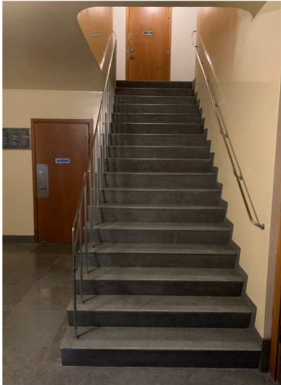
Kalkstenstrappan är rengjord från halktejp och polish och små skador, bla på nedre trappstegets utsatta ytterhörn, är lagat med stenlagningsbruk.
