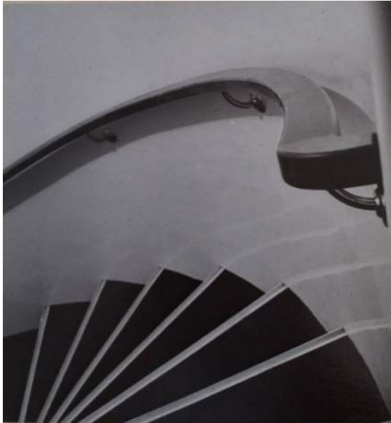
Ursprunglig trappa, 1935. OBS ingen målad sockel mot väggen, enligt ritning.
