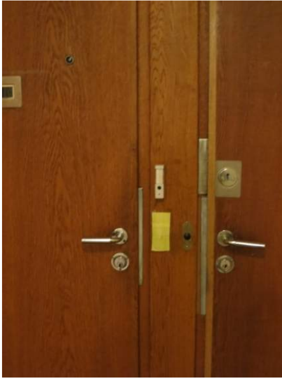
Justering och översyn av alla dörrbeslag utförs innan målning.
