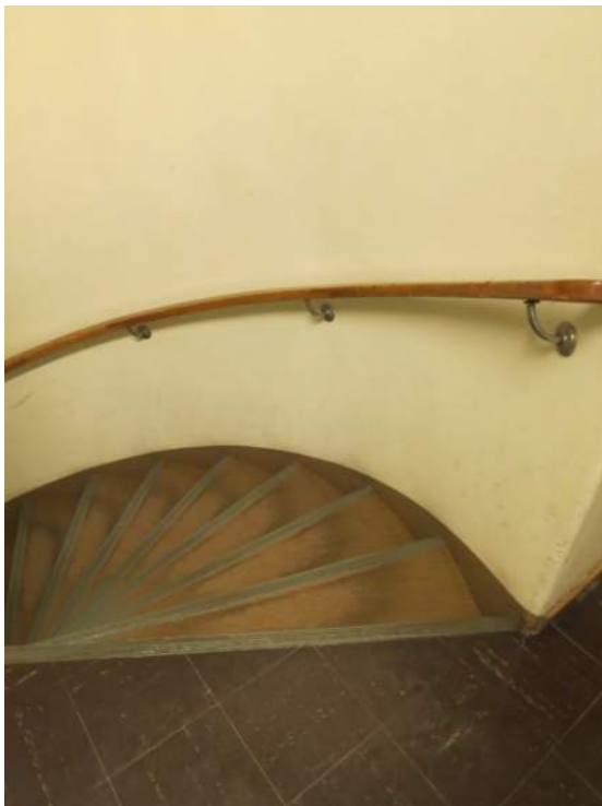
Ta ställning till befintligt golv på vilplan och i trappa inkl trappnosar.
