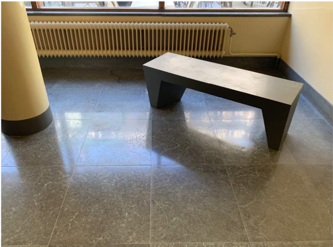
Kalkstenen har återfått sin lyster efter varsam polering.
