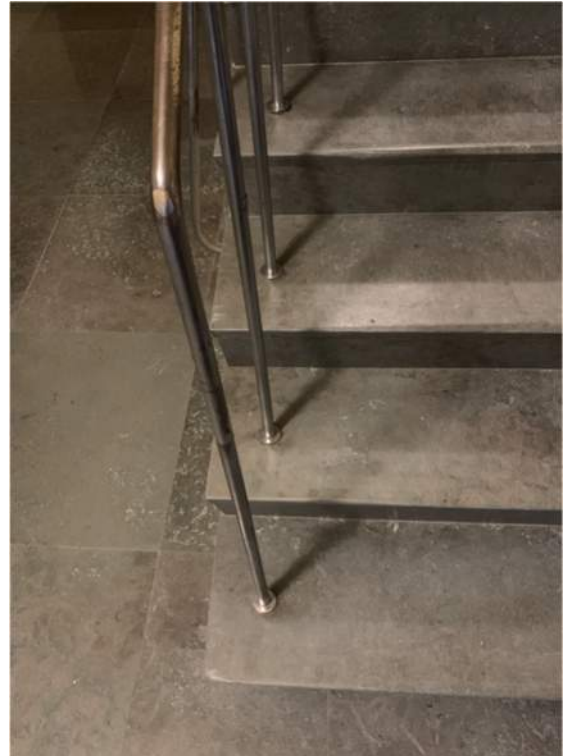
Kalkstenstrappan är rengjord från halktejp och polish och små skador, bla på nedre trappstegets utsatta ytterhörn, är lagat med stenlagningsbruk.
