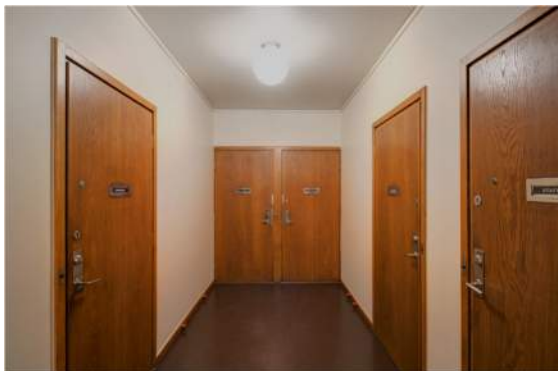
Entrédörrarna har ytskiktsrenoverats genom rengöring och oljning/vaxning. Samtliga beslag har behållits, skyltning hålls enhetlig enl brf's regler.
