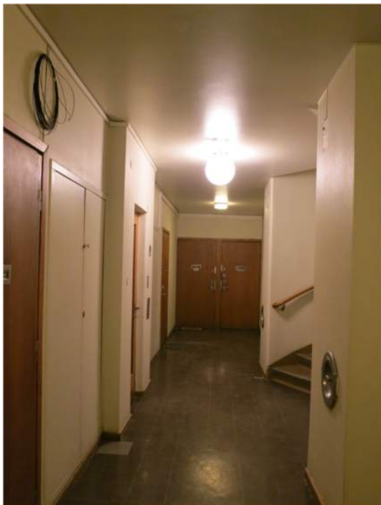
Provvarmatur, rund glob provas framför hissen. Längre bort sitter fortfarande en rund, platt kvar från 1970-talet. Ny kabellist monterad vid tak och fiberdragningarna är påbörjade.
