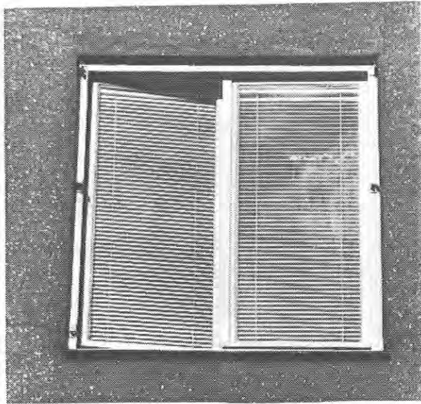
Ursprungligt träfönster, Gärdet figur 8.
