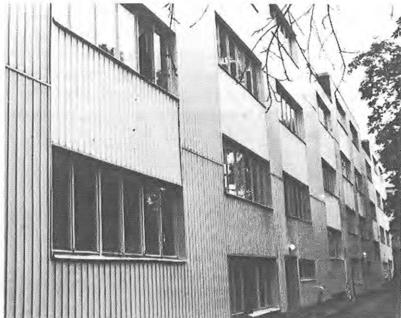
Plåtinklätt hus i kvarteret Gräset , figur 2.
