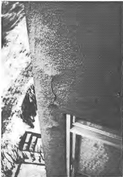
Fasaddetalj vid besiktningen 1988, figur 25.
