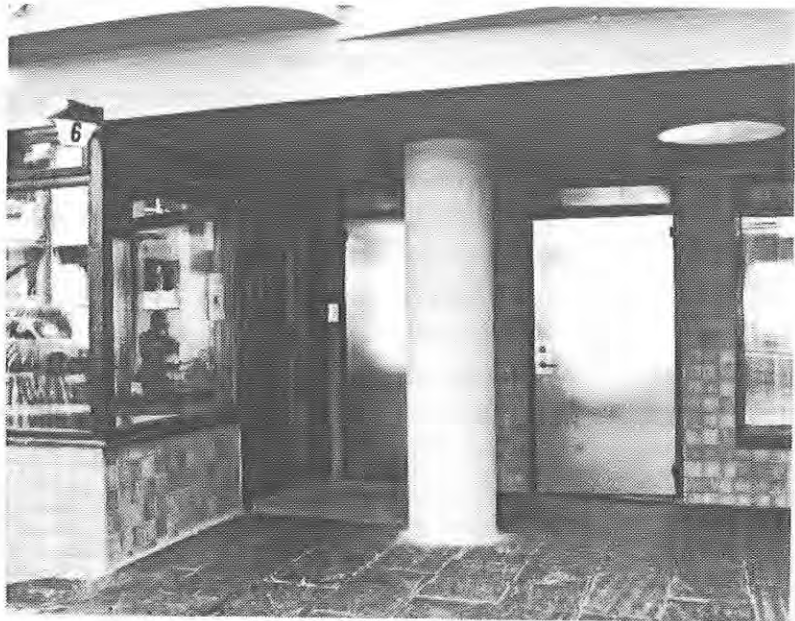
Nya soprumsdörrar vid entrén, figur 24.
