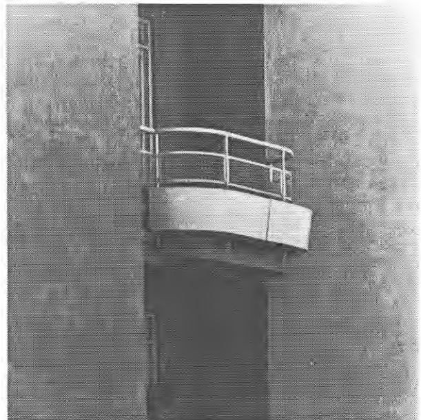
Fasaddetalj efter renoveringen, figur 26.
